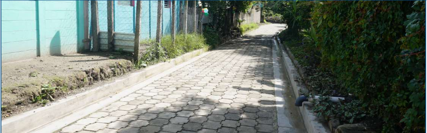
Soyapango Finalización de adoquinado.
